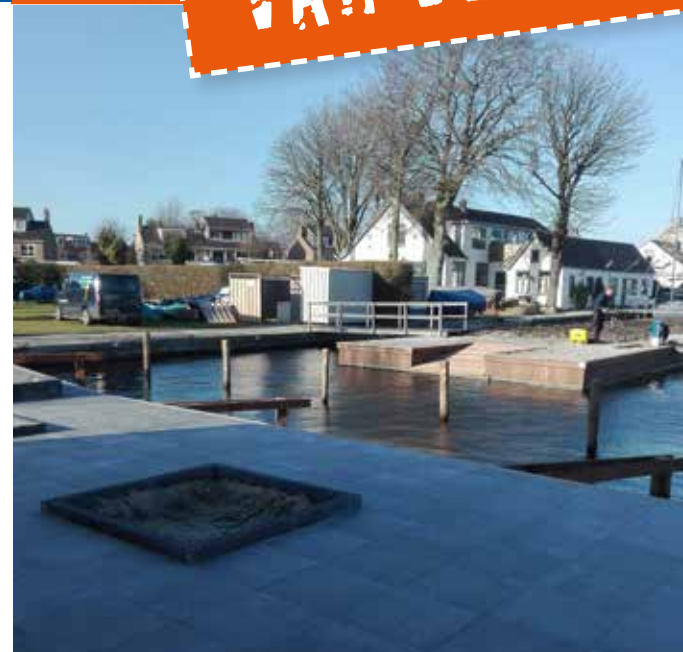
Het eilandje is opnieuw beschoeid en het straatwerk en gras worden nog gelegd
