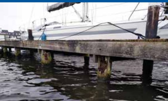
Zeer slechte palen en gebroken schoeiing, vervanging is hard nodig.
