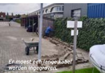
Verlichting aanleggen in de fietsenstalling op haven Oost
